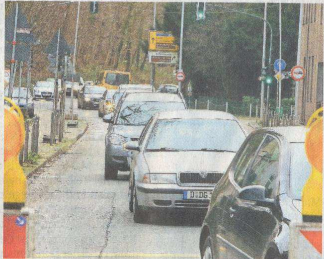
An der Glashüttenstraße zeigt sich während der Kanalbauarbeiten, wie anfällig die Trasse ist. Die Staus reichen bis Vennhausen. Foto: Young
